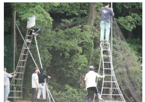
グラウンド整備(ネット補修)
